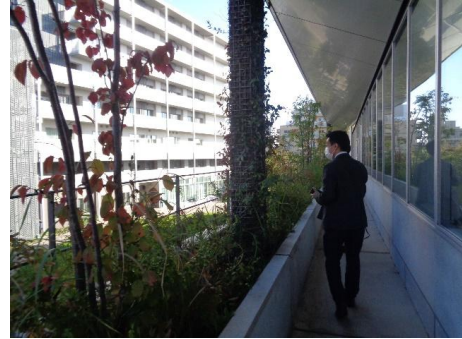
●各階外周部の植栽とジャカゴ樋（2階）
